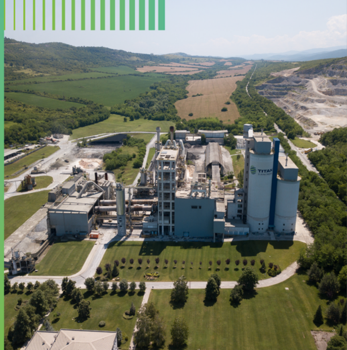
Εργοστάσιο τσιμέντου Kosjeric, Σερβία
