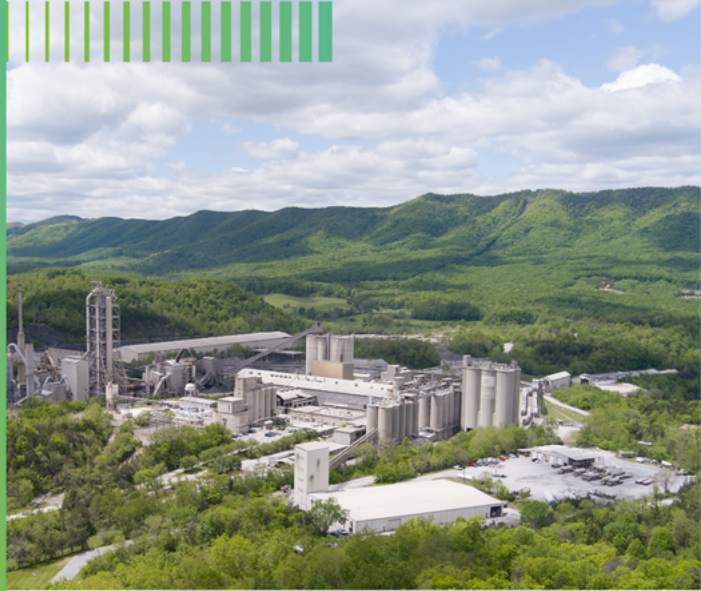
Εργοστάσιο τσιμέντου Roanoke, ΗΠΑ
