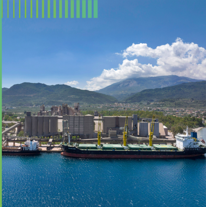
Εργοστάσιο τσιμέντου, Πάτρα
