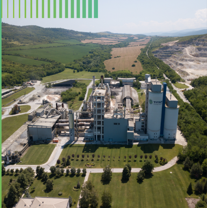
Εργοστάσιο τσιμέντου Kosjeric, Σερβία
