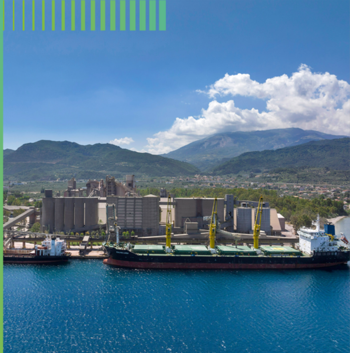
Εργοστάσιο τσιμέντου, Πάτρα
